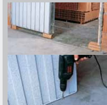
5a. Fijación sobre pavimento por terminar.
