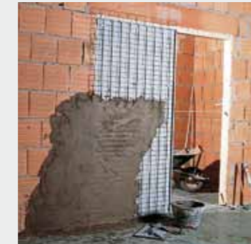
8. Una única capa de enfoscado será suficiente ya que el armazón se suministra preenfoscado.
