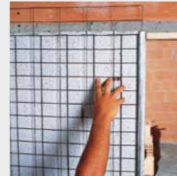
7. Fijar la red metálica con los clips suministrados.
